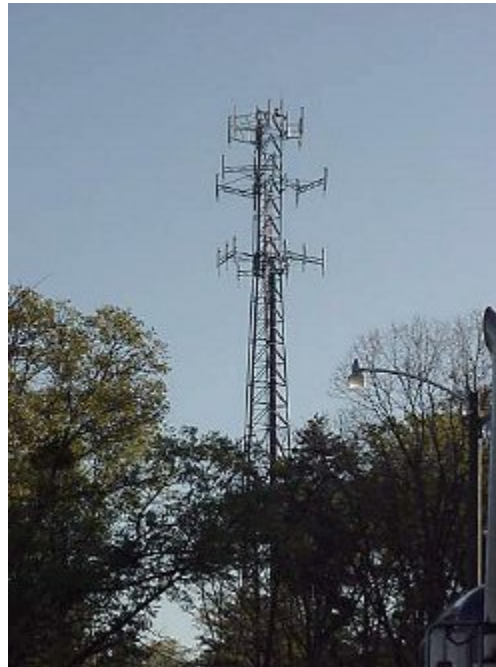
Maststandort ca. 10-40 W
